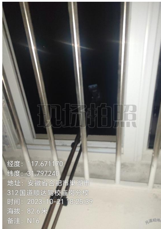
N16: 20#住宅楼 504 窗外 1m
